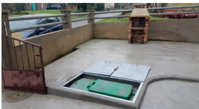
Pose en cour fermée
